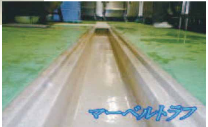
マーベルトラフ (排水溝) 施工図
