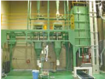
製粉工場（黄な粉）フレコン取り
