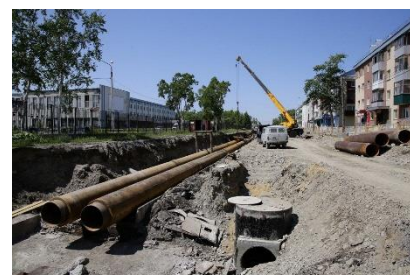
給水パイプの修繕現場
