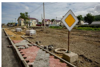
道路工事現場
