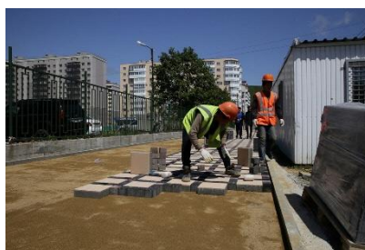
歩道整備現場
