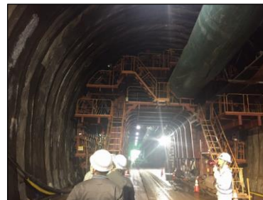
北海道新幹線_昆布トンネル現場
