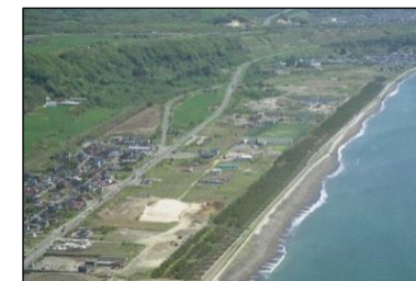
海岸防災林 (津波の減衰対策)
