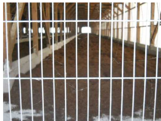
幅の狭い金網で小型鳥類の侵入を防止している例
