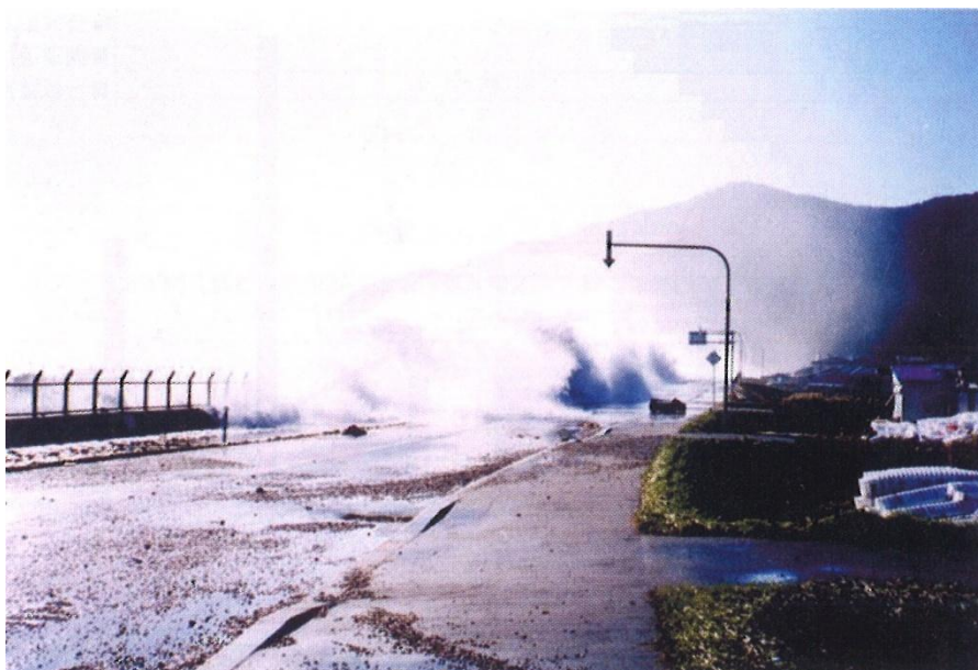
写真－12 越波の様子 (知内町)
