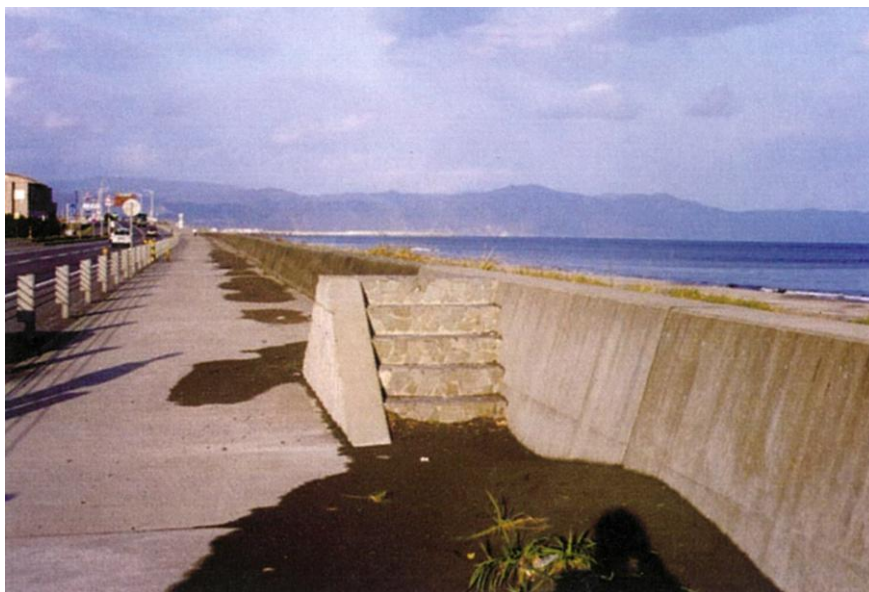
写真- 34 護岸から砂浜への階段（長万部町）
