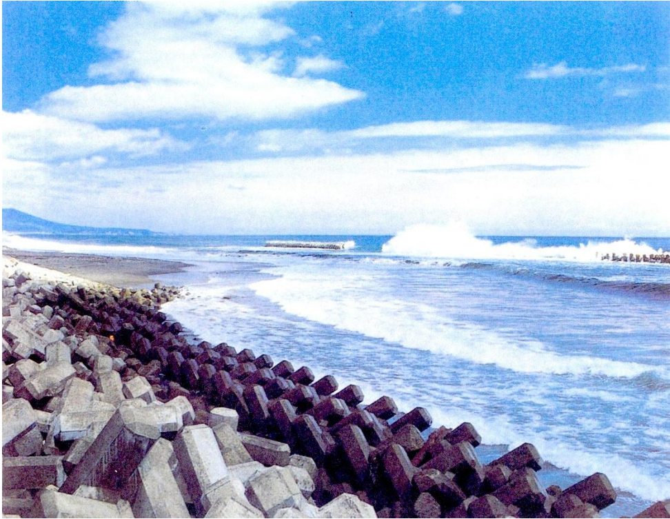
写真- 14 登別市に設置されている海岸保全施設の例（離岸堤 51 ）
