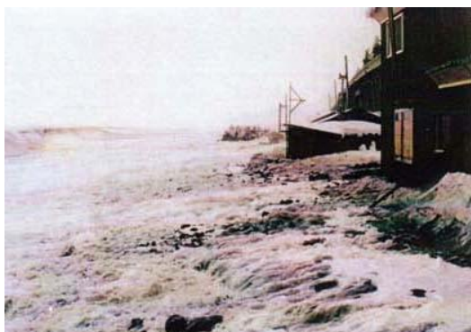
越波状況（羅臼海岸ケンネベツ地区）
