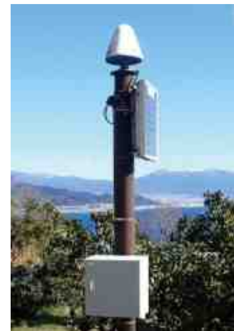
GNSS観測機の設置事例※3
