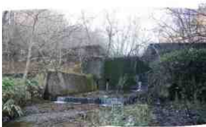
砂防堰堤（軽川）
