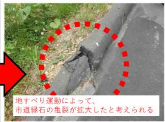
市道縁石の亀裂 （撮影月：令和7年6月） ※左写真とは別アングルで撮影したもの
