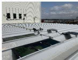
実証実験設備の取付状況（屋根）
