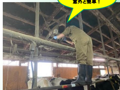
送風機の角度調整
