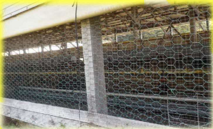
防鳥ネット設置
