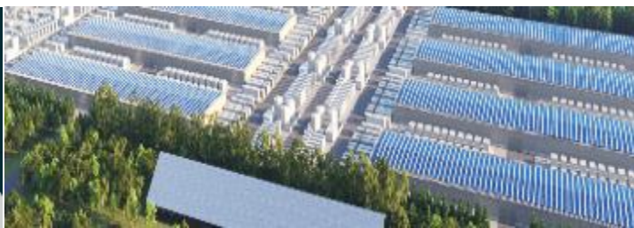
アジア最大級のAIデータセンターの 建設
