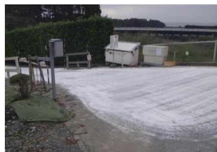
出入口への消石灰散布
