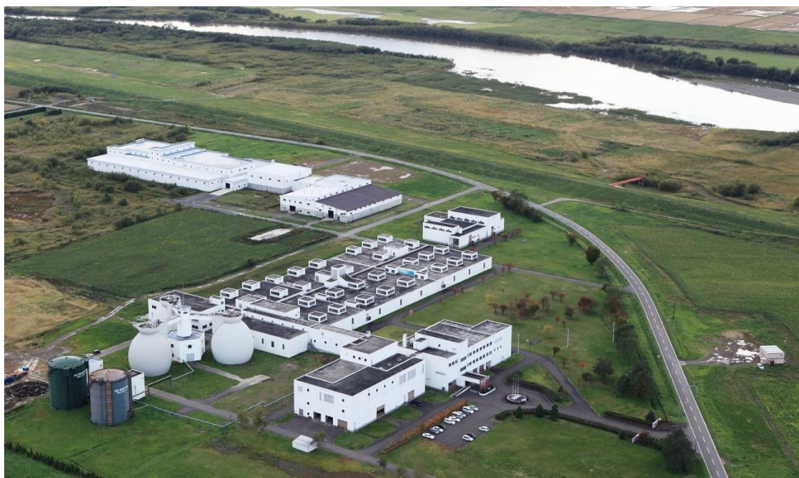
石狩川流域下水道奈井江浄化センター全景
