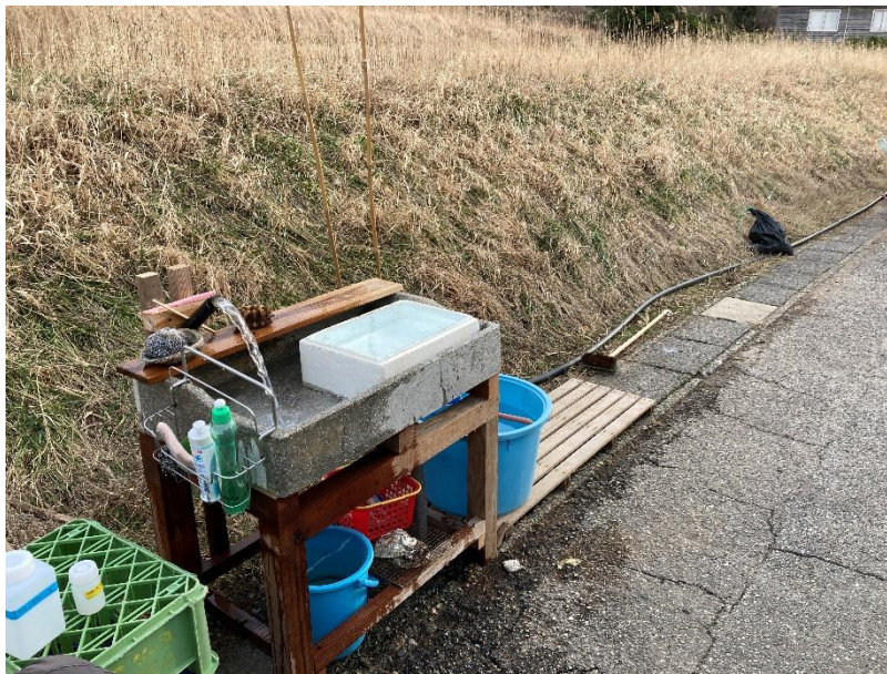
図4-2 地すべり対策水抜孔から配管を敷設し、生活用水に活用した例（石川県珠洲市）
