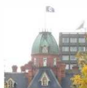
現在(改修工事前)
