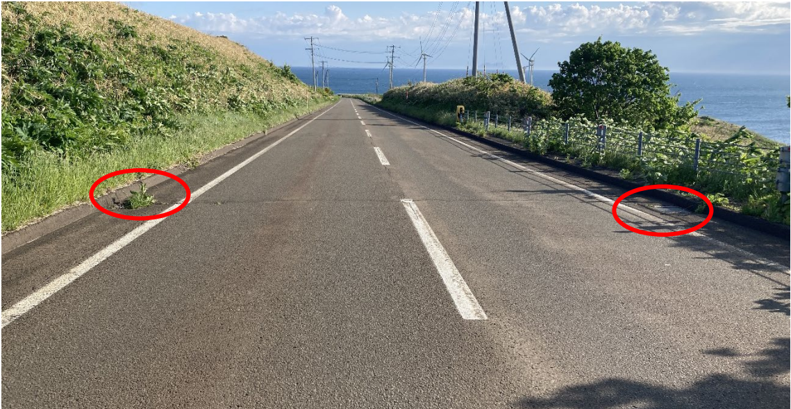
図 2 国道 228 号の路肩に横断側溝
