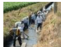
水路の泥上げ
