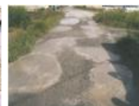
農道の窪みの補修
