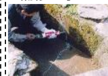
水路のひび割れ補修
