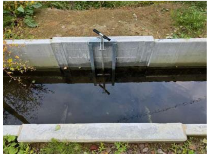
← 上流（起点）側 下流側 →
