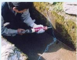
水路のひび割れ補修
