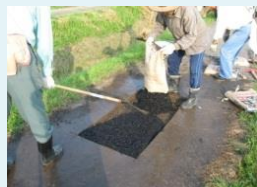
農道の部分補修
