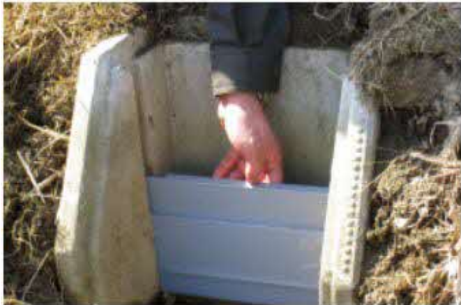
1枚の板の上下で水位調整が簡単
