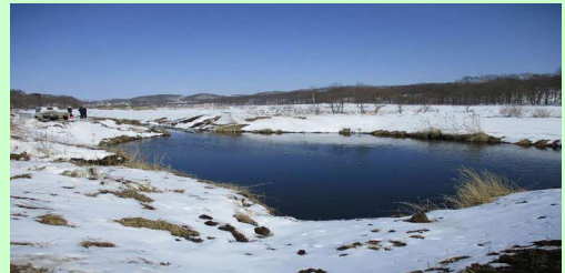
土砂を沈殿させ湿原へつながる河川に排水して、湿原への土砂流入を抑制している。(土砂上げ後) ※ 令和2年度 土砂浚渫量 544立法メートル
