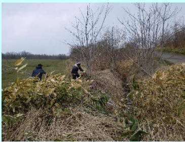
農道側溝の雑木伐採
