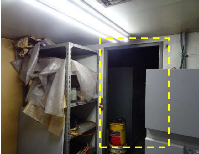
【コンプレッサー室の外気流入箇所】
