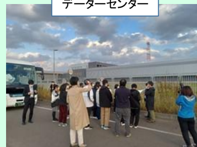
データセンター
