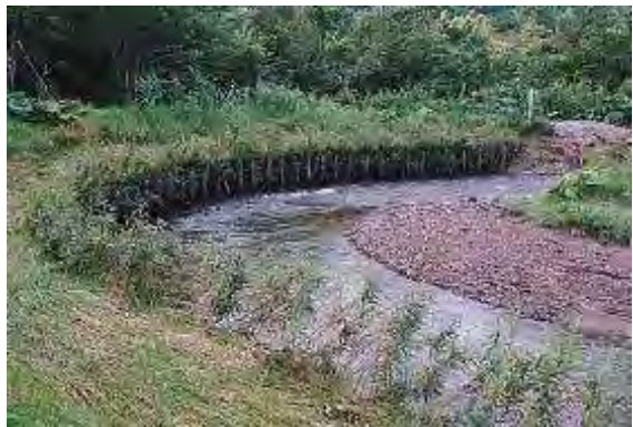
(施工 2 年後の状況)
