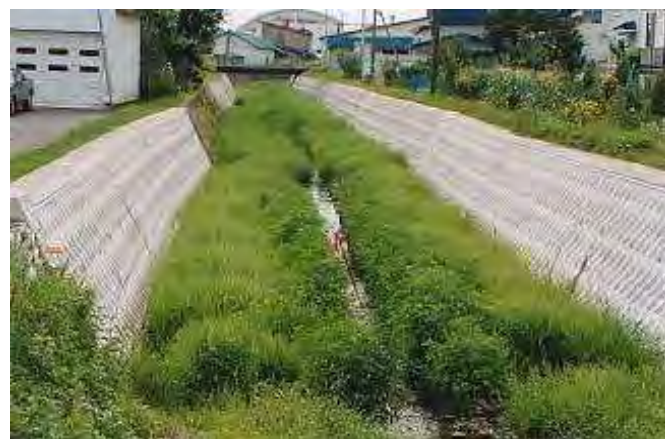
(施工1年後の状況)
