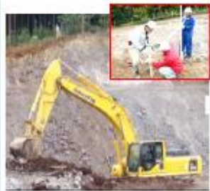
丁張りを目印に施工
