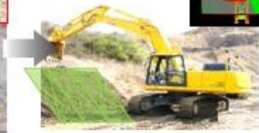
3次元設計データに沿って施工
