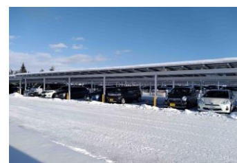
積雪時のソーラーカーポート（両面受光パネル）
