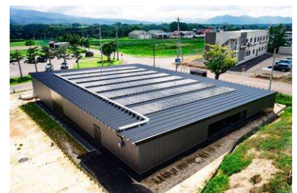
ニセコミライ地区に設置した ソーラーカーポート
