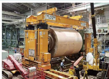
【機械据付、解体】
