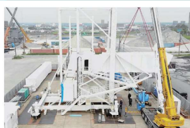
【工場外（港）での組立】
