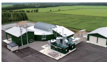
【バイオガス発電プラント】
