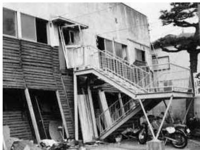
写真 2-23 屋外階段の傾斜被害(Cランク)
