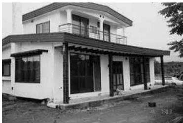
写真 2-5 建物の不同沈下(Bランク)
