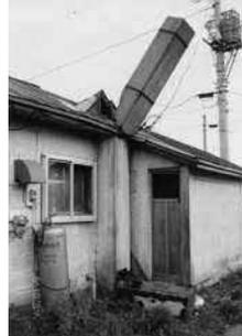
写真 2-25 煙突の転倒危険(C ランク)
