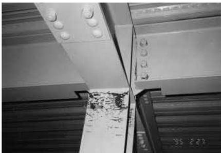
写真 3-4 柱頭の座屈による塗料の剥落 (B ランク)
