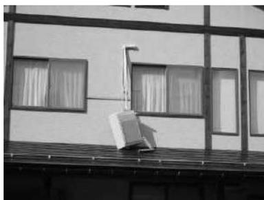
写真 2-22 エアコン室外機の落下危険(Cランク)
