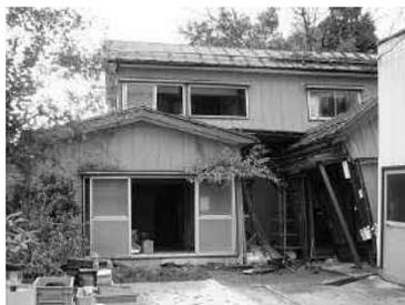
写真 2-16 窓枠の歪み(Bランク)
