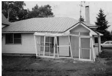
写真 2-6 建物の不同沈下(Cランク)
