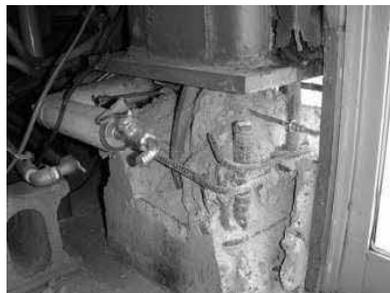
写真 3-2 基礎の著しい破損
