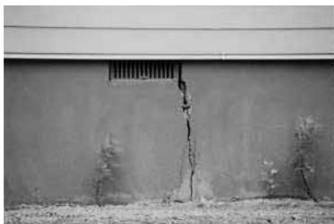
写真 2-7 基礎の亀裂(Bランク)
