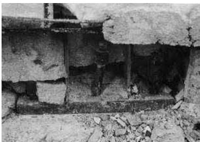
写真 3-8 柱脚のアンカーボルトの引き抜け
