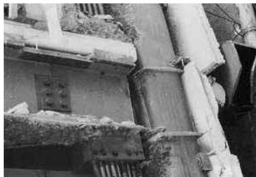
写真 3-7 梁仕口部の溶接部分の破断
