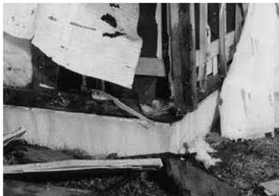
写真 2-13 土台、柱の腐朽(Cランク)
