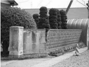
写真 2-24 ブロック塀の転倒危険(C ランク)
