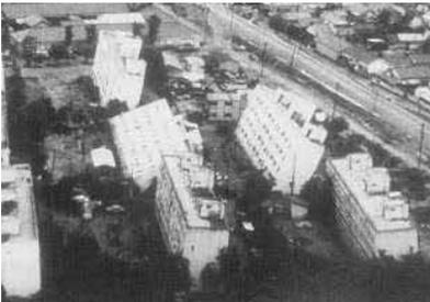
写真 4-13 全体沈下と全体傾斜
