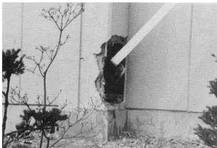
写真 3-5 筋違の破断
