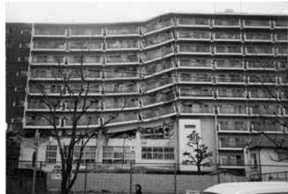
写真 4-14 構造躯体の損傷による部分的な傾斜
