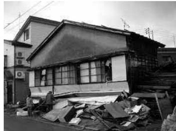
写真 2-2 低層階の崩壊
