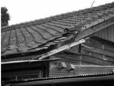
写真 2-14 屋根瓦の落下損傷(Bランク)
