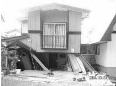
写真 3-1 著しい構造的被害
