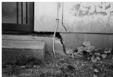
写真 2-8 基礎の破断(Cランク)
