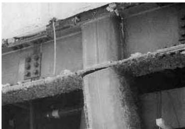
写真 3-6 柱頭での柱溶接部の破断
