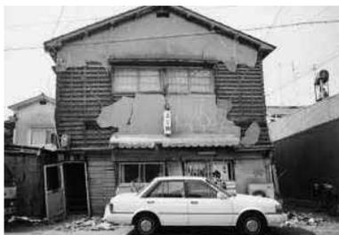
写真 2-11 外壁の被害(Cランク)
