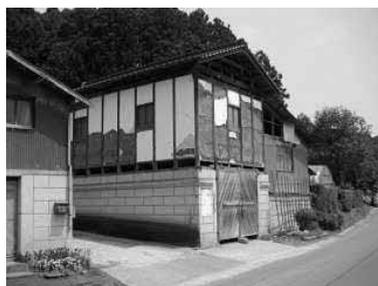
写真 2-18 土壁の剥落(Cランク)
