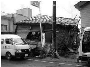
写真 2-3 隣接する建物の傾斜(Cランク)
