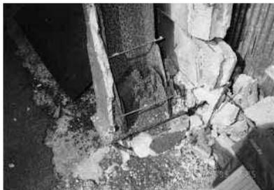
写真 3-11 柱脚の腐食 (C ランク)
