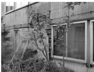
写真 2-19 モルタル壁の剥落(Bランク)
