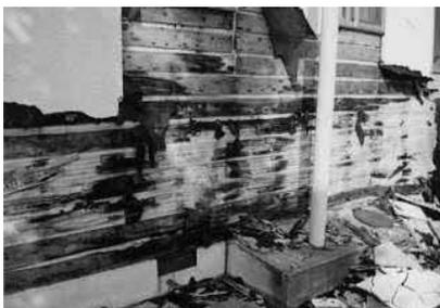
写真 2-12 下地材の腐朽(Bランク)
