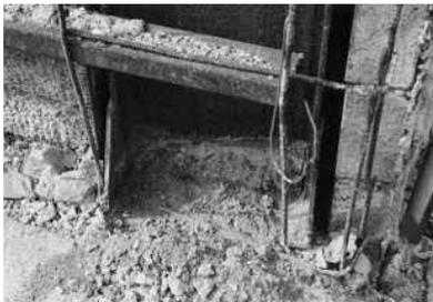
写真 3-10 柱と胴縁の腐食 (C ランク)
