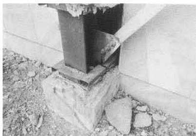
写真 3-9 柱脚コンクリートの部分破壊
