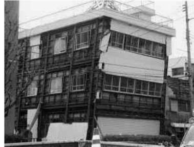
写真3-3 傾斜による外装材の剥落
