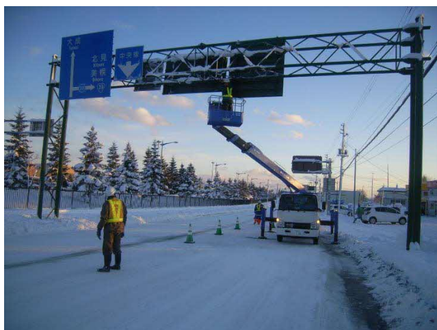
近接目視作業状況の例
