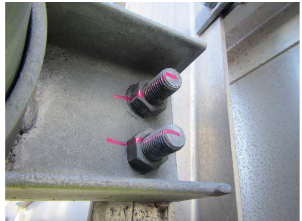
ボルトの再締付例
