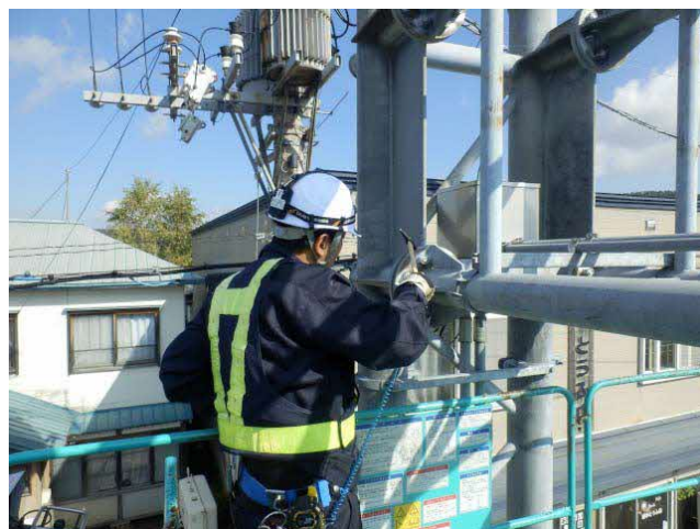
ボルト打音検査作業状況の例
