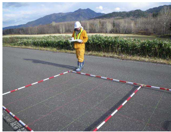
目視による路面ひび割れの点検例（ひび割れ率評価）
