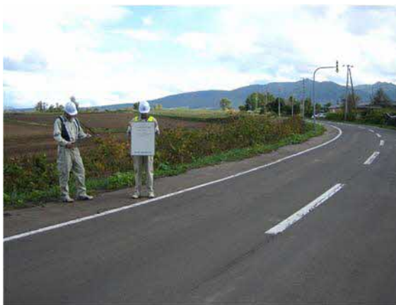
目視による路面ひび割れの点検例（Ⅰ～Ⅲランク評価）
