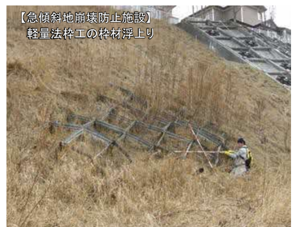
写真 2-2 砂防関係施設の損傷・劣化の状況
