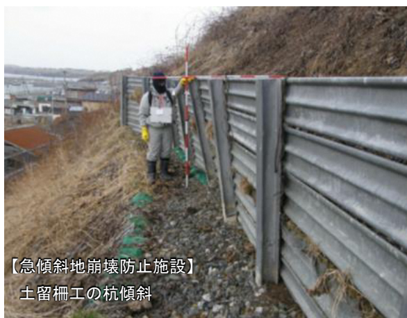
写真 2-2 砂防関係施設の損傷・劣化の状況
