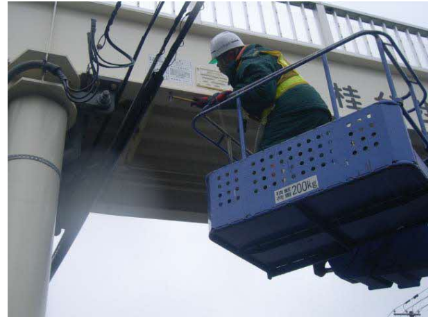
横断歩道橋の近接目視作業状況の例
