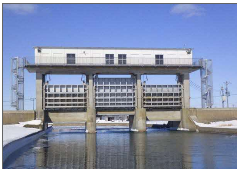
写真 2-4 新川水門全景
