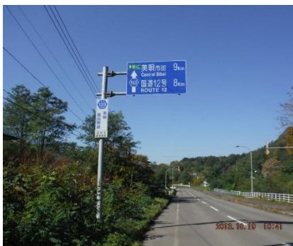
大型道路標識
