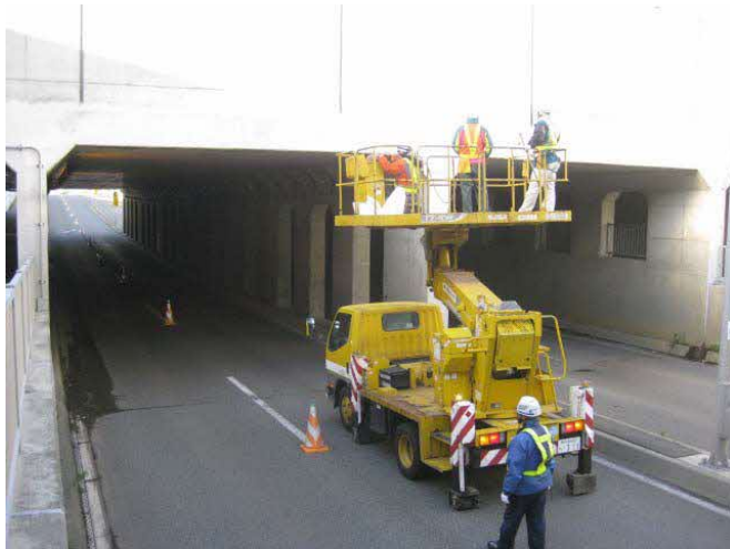
大型カルバートの近接目視作業状況の例
