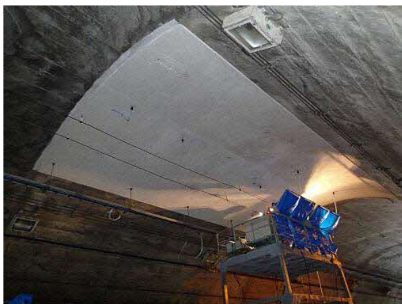
写 5-1 修繕工事例 (裏込め注入)
