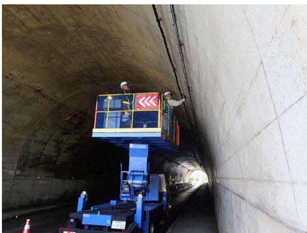
近接目視作業状況の例
