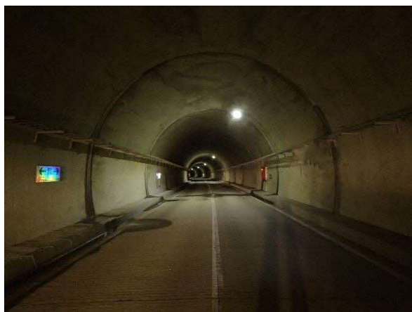
写 5-2 修繕工事例 (面導水設置)
