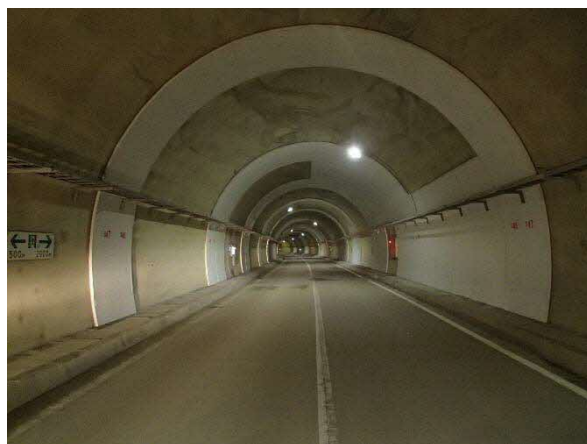
写 5-2 修繕工事例 (面導水設置)
