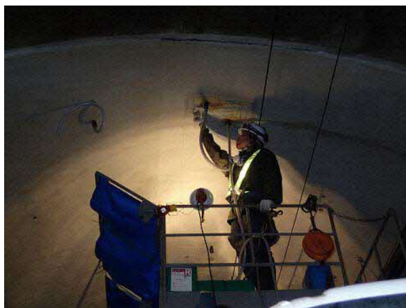
写 5-1 修繕工事例 (裏込め注入)
