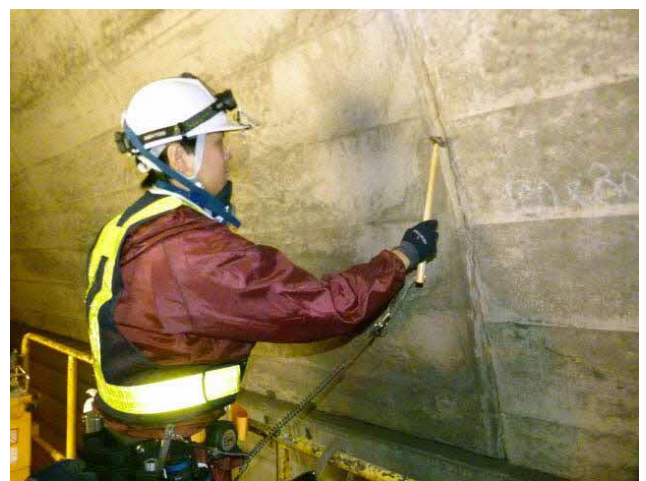
打音検査作業状況の例
