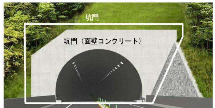
図 5-2 道路トンネル施設一般図
