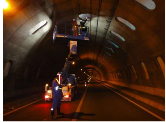
シェルターの近接目視作業状況の例
