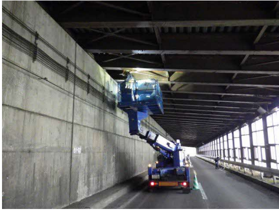
シェッドの近接目視作業状況の例
