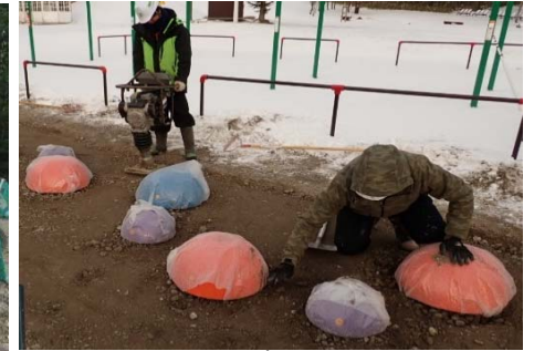
写真2 使用禁止遊具の更新工事 ハーフポール遊具設置状況 （ゆめの森公園〈中標津町〉）
