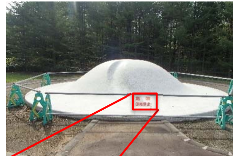
写真1 遊具の使用禁止状況 （サンピラパーク〈名寄市〉）
