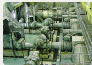
鷺別ポンプ場
