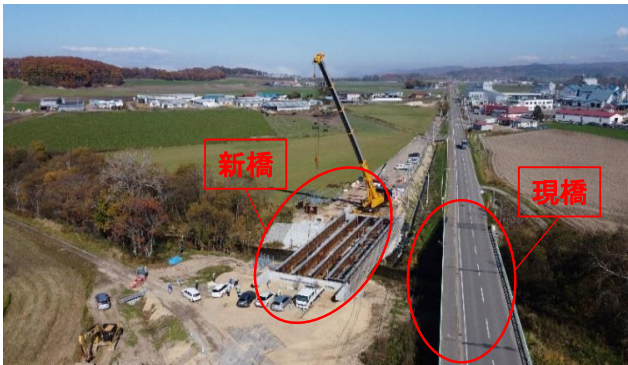
R5年度施工風景（桁架設）
