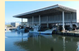
荷さばき施設など水産施設の整備
