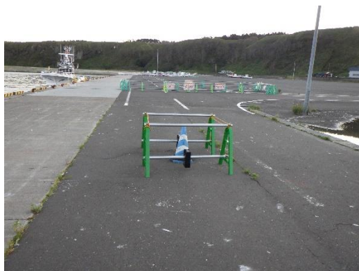
写真① 漁港施設の立入禁止措置状況（落石漁港〈榎室市〉）
