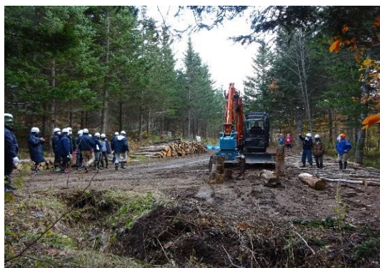
林業機械（グラブ）操作体験の様子
