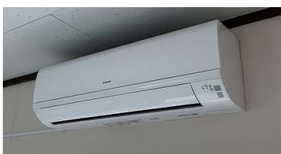
灯油暖房機をエアコン化
